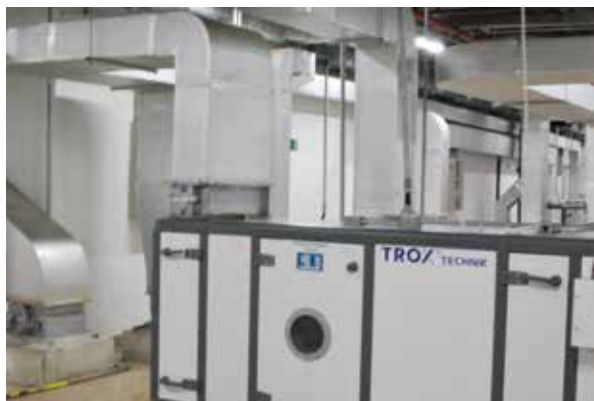
Casa de máquinas
