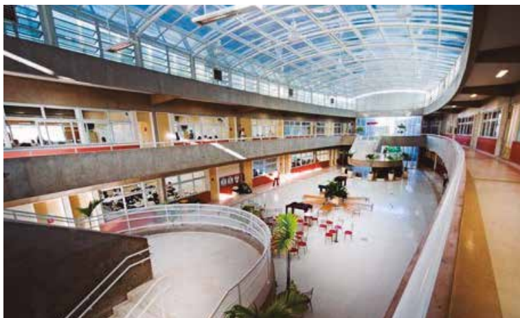
Escola do SESI/SP - edificação apropriada para instalações de resfriamento evaporativo
