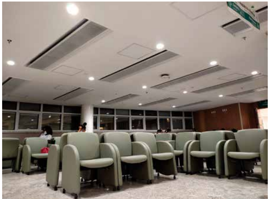
Vigas frias garantem as condições de conforto e a qai (Divulgação JAM)
