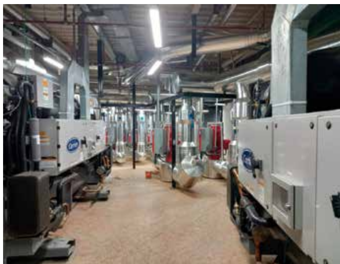
Produção de água gelada com chillers parafuso (Divulgação JAM)
