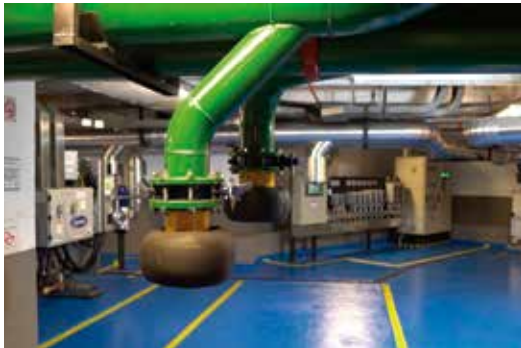
CAG 1: substituição de dois chillers
